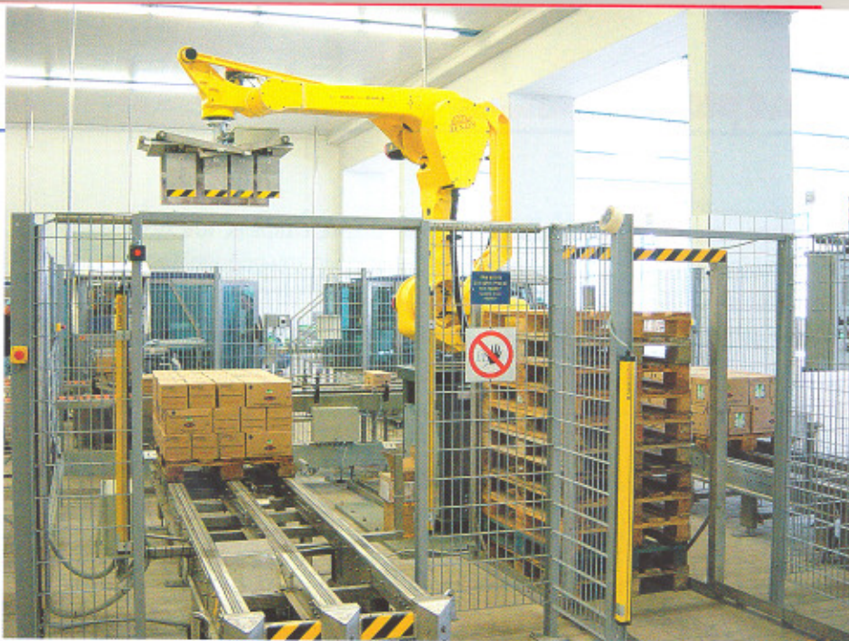
Τα ρομποτικά συστήματα παλετοποίησης τοποθετούνται μετά από τη δευτερογενή συσκευασία και χρησιμοποιούνται για το αυτόματο χτίσιμο της κάθε παλέτας.
